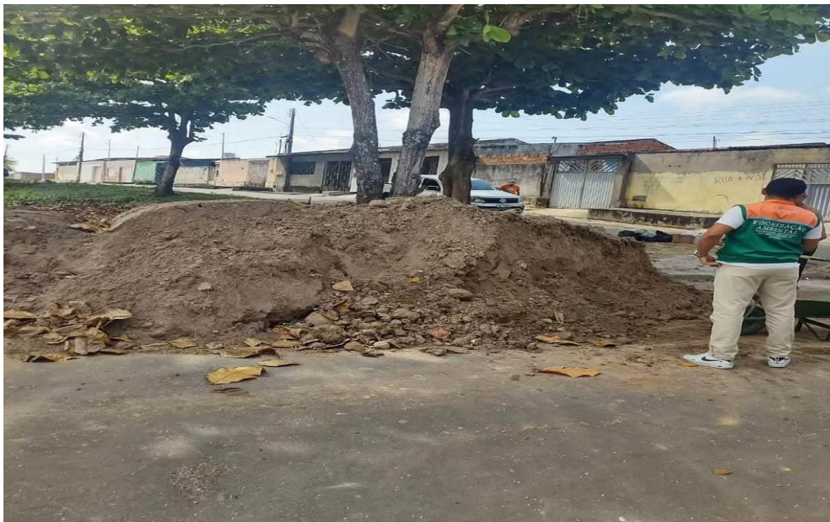
Fiscalização e monitoramento após denúncias de atividade de aterramento e obstrução de córrego.
